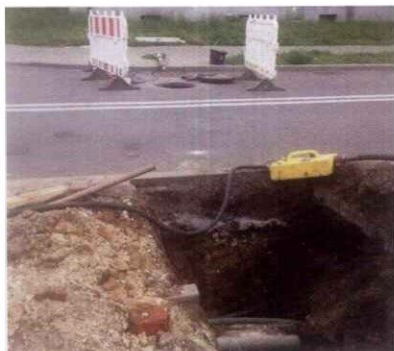
Fot. 1. Miejsce wykonywanego przyłącza
