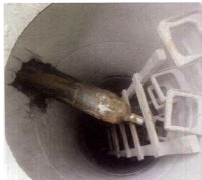
Fot. 2. Przebiecie się w studni
