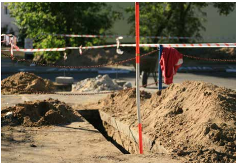
Wykonany wykop start i koniec
